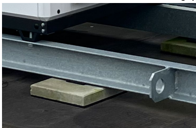
Detailfoto van ondersteuning met trillingsdempend matje.
