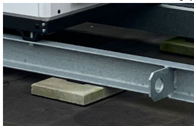
Detailfoto van ondersteuning met trillingsdempend matje.
